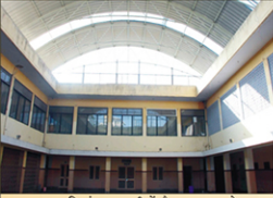
नसियां भट्टारकजी में जैन भवन पर डोम का निर्माण।
